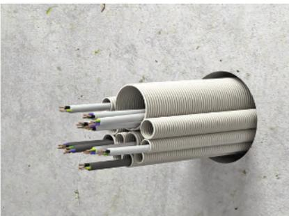
Installationsrohre mit oder ohne Kabelbelegung in die Öffnung einlegen. Die Elektroinstallationsrohre müssen mindestens 20 cm über die Wand / Decke hinausragen.
