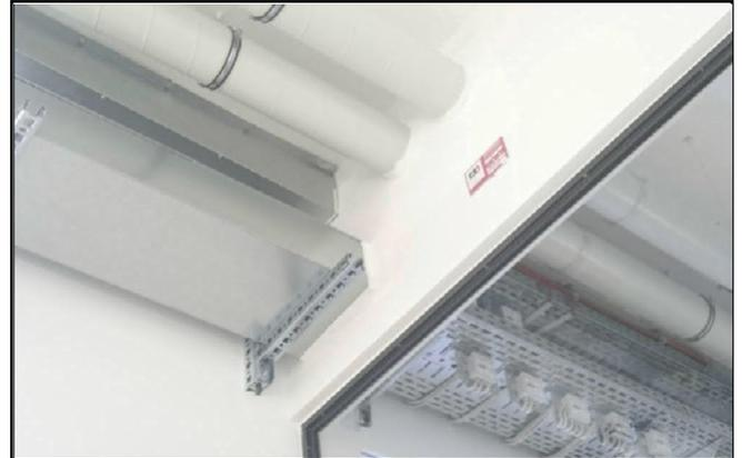
**Anwendung:** Geprüftes Fertigkanalsystem für Funktionserhalt von sicherheitsrelevanten Leitungen und Brandlastdämmung in Flucht und Rettungswegen.
