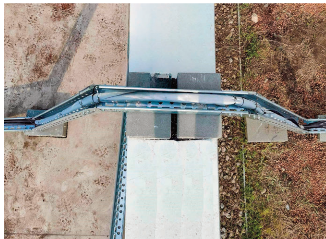
Leitungsführung über Brandwände (Abb. ohne Deckel)
