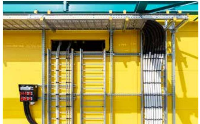
Das Unternehmen Eberhard hat auf dem firmeneigenen Areal in Rümlang ZH eine grosse Lagerhalle mit Photovoltaikanlage errichtet. Die LANZ EcoShield® Kabelbahnen, Deckel, Multifix C-Profile, Weitspann-Multibahnen und Multibahnen sowie diverses Befestigungsmaterial eignen sich bestens für die Kabelführung und die Installation von Wechselrichteranlagen im PV-Bereich.
