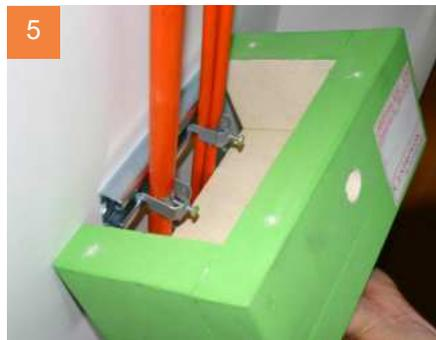
5 Das Unterteil mittig zur Systemschiene an die Kabel halten.
