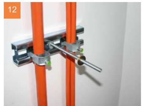
12 Die Anzahl der Gewindestangen entspricht den Löchern auf der Vorderseite der ABSfixss.
