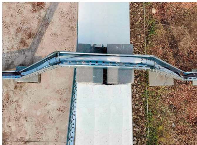
Leitungsführung über Brandwände (Abb. ohne Deckel)
