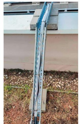
Leitungsführung über Brandwände (Abb. ohne Deckel)
