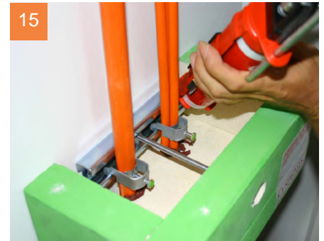
15 Die Öffnungen zwischen Kabel und ABSfixss mit Brandschutzsilikon verschließen. Bei großem Ausschnitt den Leerraum zwischen Kabel und Wand mit beigelegtem Streifen und Brandschutzsilikon ausfüllen.
