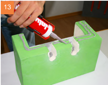
13 Auf die der Wand zugewandten Fläche des Unterteils Brandschutzsilikon auftragen.
