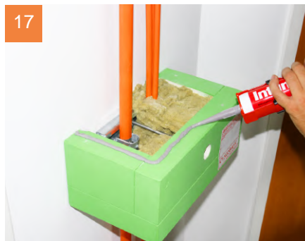
17 Auf den Oberkanten des Unterteils und auf der mauerzugewandten Kante des Deckels Brandschutzsilikon auftragen. Den Deckel aufsetzen und mit dem Unterteil handfest verschrauben.
