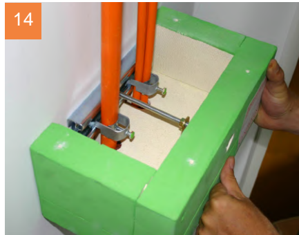
14 Die Gewindestange(n) einfädeln, Unterteil über die Systemschiene stülpen und mit Gegenmutter und Mutter fixieren.
