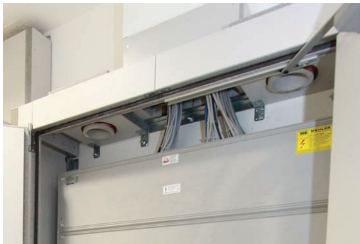
Sowohl die Ab- und Zuluft als auch die Kabelführung sind werkseitig brandbeständig vorgefertigt.
